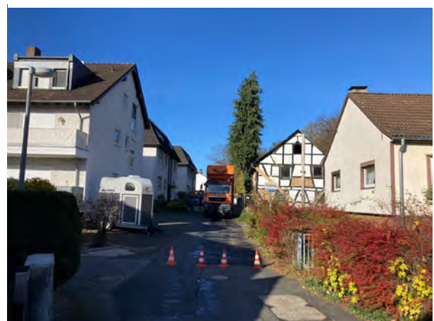
Abbildung 19: Gehwegsanierung in Lohmar (Foto: Stadt Lohmar)
