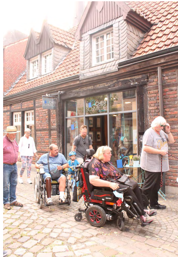
Abbildung 4: Nicht barrierefreie Infrastruktur in der Altstadt Billerbeck (Foto: Planersocietät)
