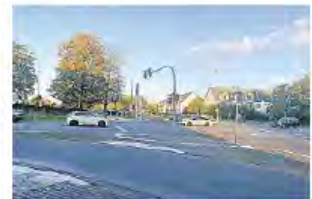
Die Ampelanlage an der Kreuzung Walthovener Straße/B9 soll angepasst werden.
